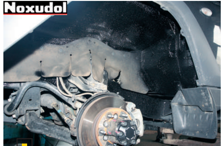
Пленка Noxudol UM-1600, нанесенная методом безвоздушного распыления под высоким давлением
