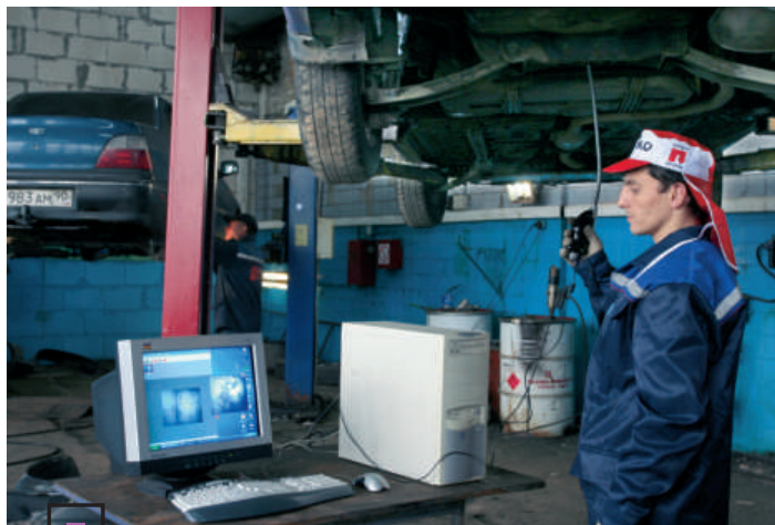
■ Перед обработкой б/у автомобилей необходима диагностика состояния полостей кузова. Ее проводят с помощью бороскопа, соединенного с компьютером.
