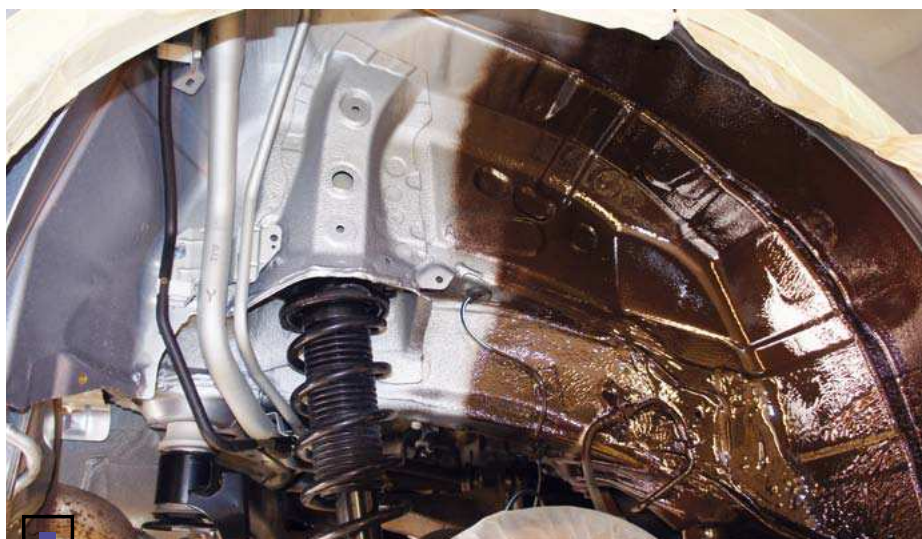
Обработка колесных арок материалом Mercasol 845 AL с наполнителями (алюминиевый порошок и полимерные микросферы). Обратите внимание на границу между заводским покрытием и защитной пленкой. Еще несколько движений пистолетом — и вся арка станет темно-коричневой с «бронзовым» оттенком. Именно такой цвет имеет пленка Mercasol 845 AL
